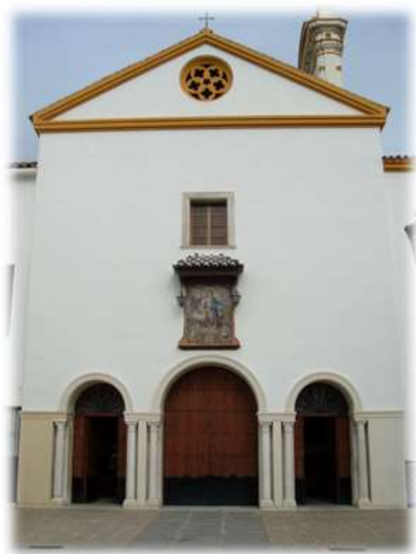
Fachada de la iglesia conventual de Capuchinos en la Ronda
