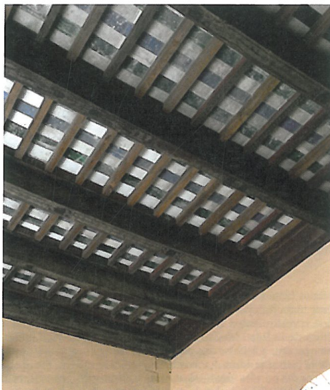
2 CASA DE LOS PINELO. PLANTA BAJA. TECHO DEL APEADERO. HACIA 1500.
